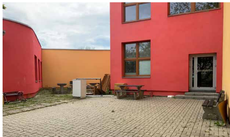
Obr. 5 Prostor se zámkovou dlažbou při jihovýchodním rohu školní budovy je příležitostně využíván jako provizorní venkovní učebna.
