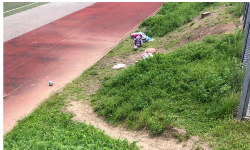
Obr. 15 Na svahu mezi klecí a běžeckým oválem byly odstraněny vzrostlé stromy, prostor vyšlapán dle potřeb uživatelů, nezajištěný svah podléhá erozi.
