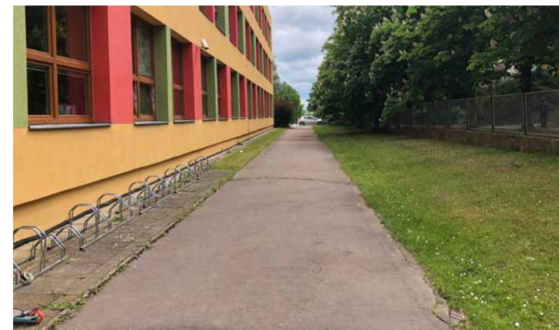
Obr. 8 Pozemek při západní fasádě budovy lemuje alej jírovců (za hranicí pozemku), nachází se zde stojan na kola.
