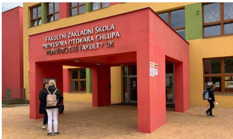
Obr. 2 Krytý vstup do budovy školy
