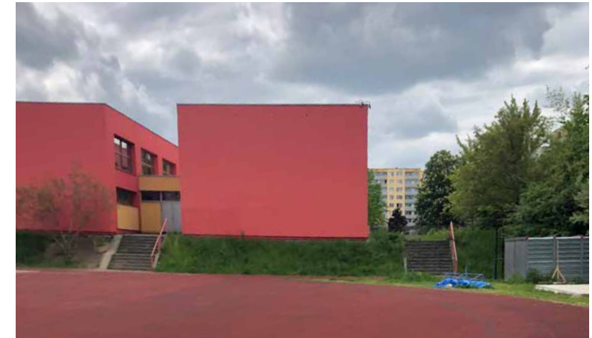
Obr. 17 Terénní zlom mezi tělocvičnou a oválem je propojen schody nesplňujícími bezpečnostní standardy.
