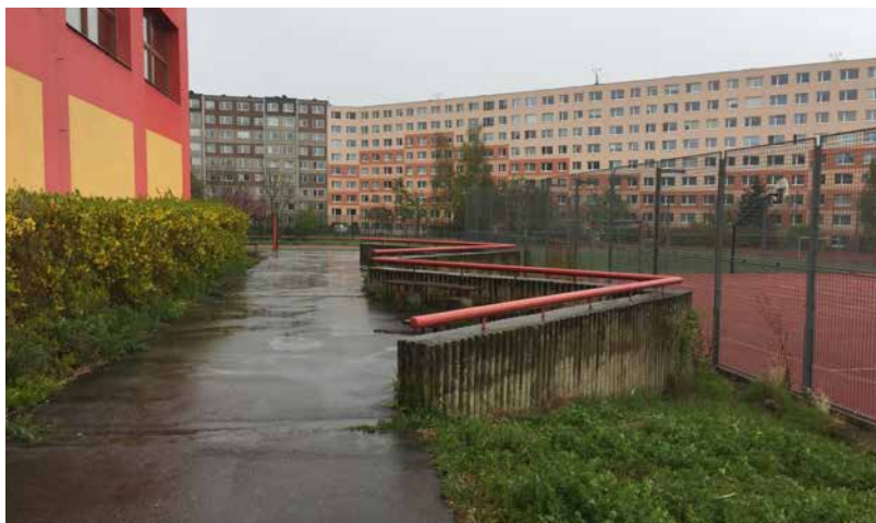
Obr. 12 Stávající pobytová zóna na jižní straně tělocvičny s výhledem na sportovní hřiště
